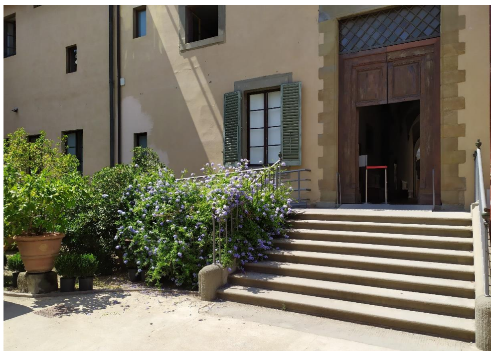
FOTO N. 4 – Foro rampa provvisoria per accesso a corte tergale
