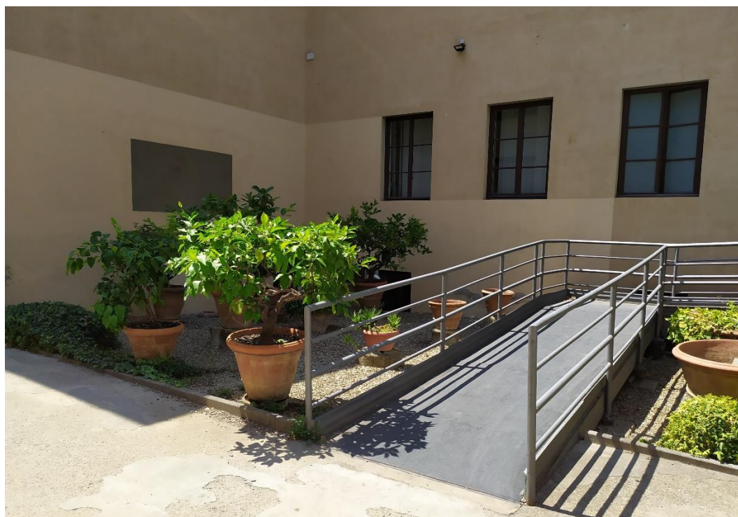
FOTO N. 5 – Foro rampa provvisoria per accesso a corte tergale
