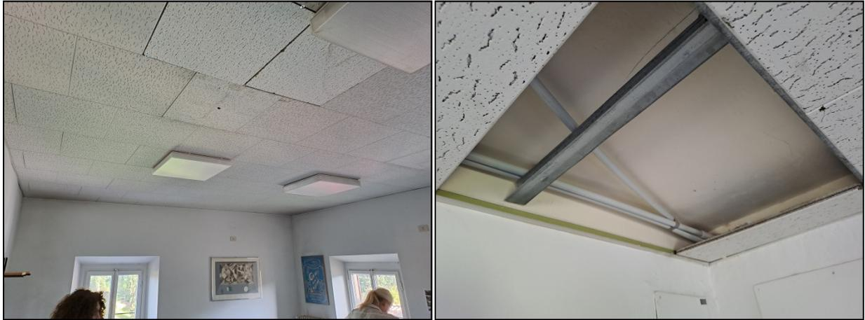
Esempio di controsoffitto acustico smontabile con solaio piano sovrastante.
