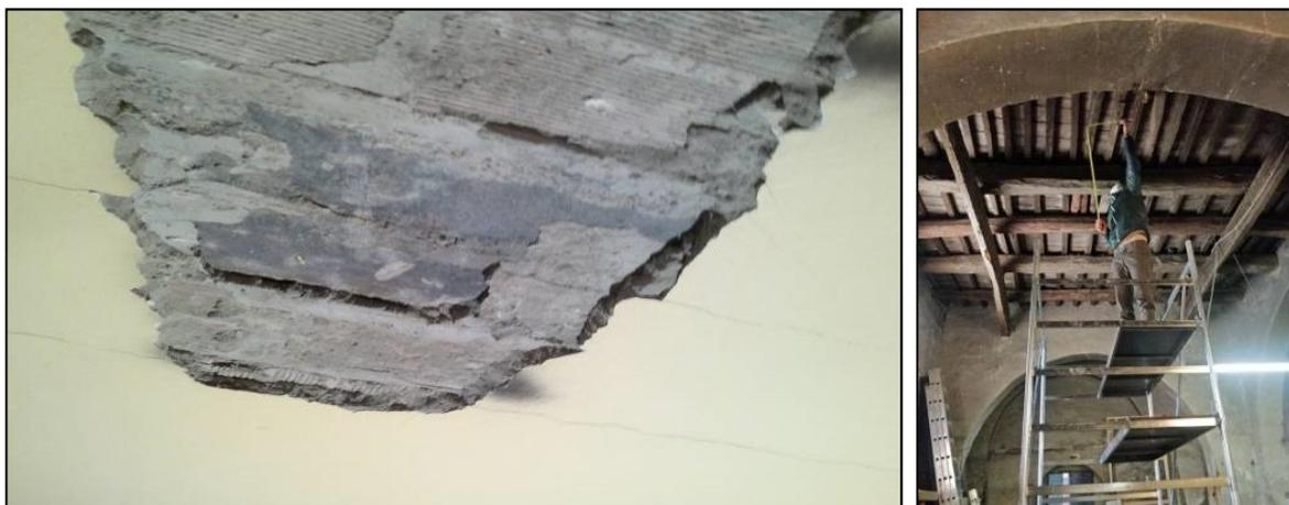
Esempio di stonacatura a soffitto e di trabattello per rilievo degli elementi lignei.
