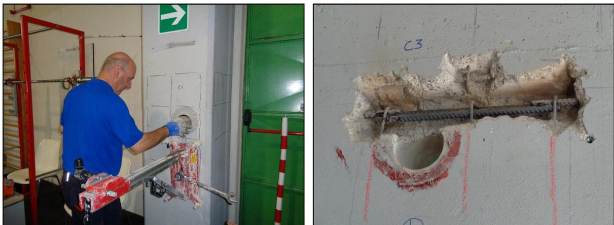
Esempio di carotaggio su pilastro in C.A. e prelievo di armatura
